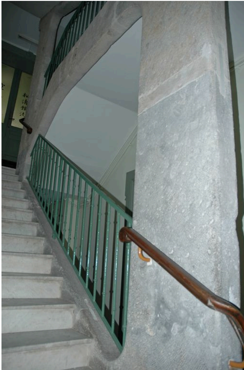
105 grande rue de la Guillotière : détail de l'escalier
