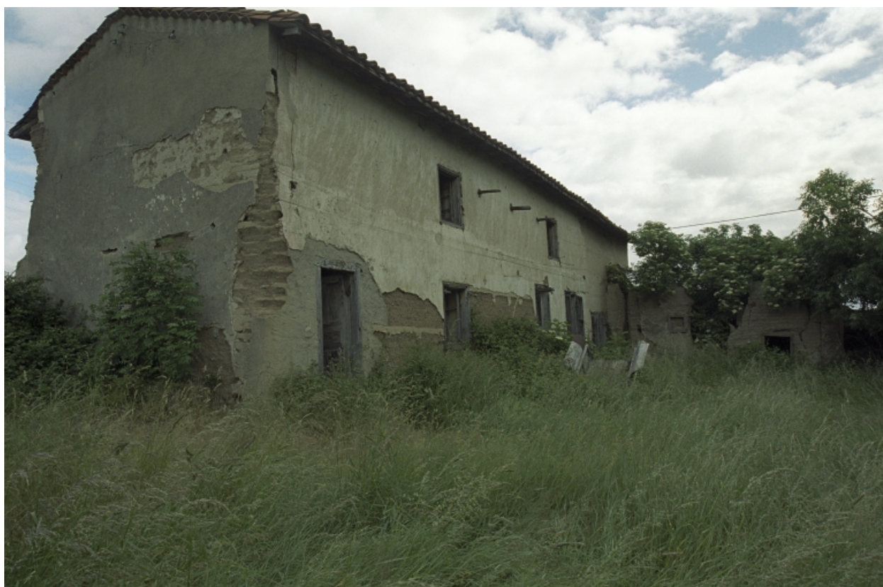
Bussy-Albieux, Gouttebelin (1987 D2 689), type C2. Vue d'ensemble du logis.
