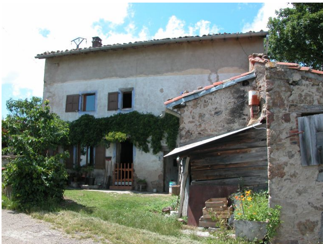
Vue d'ensemble des façades sur cour.
