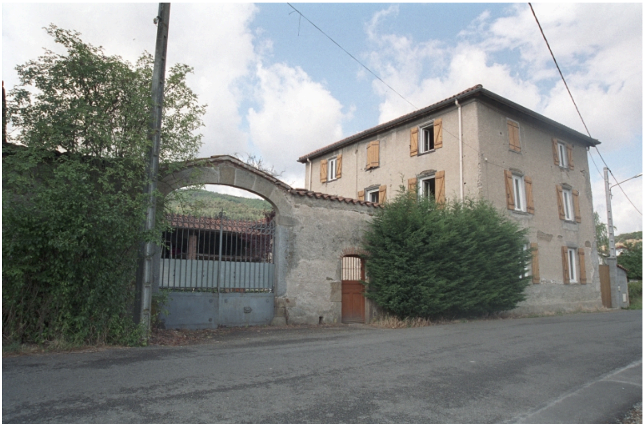
Aux Places, ferme (1986 A1 312, 856), vue d'ensemble de la ferme depuis la route.
