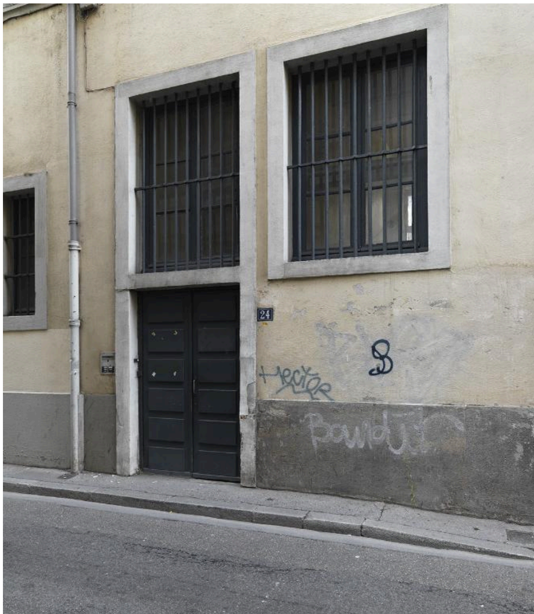
Elévation latérale nord, porte menant à l'escalier C
