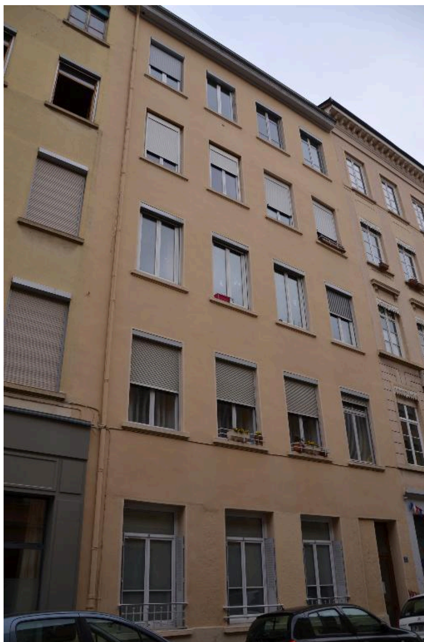
Vue d'ensemble façade sud
