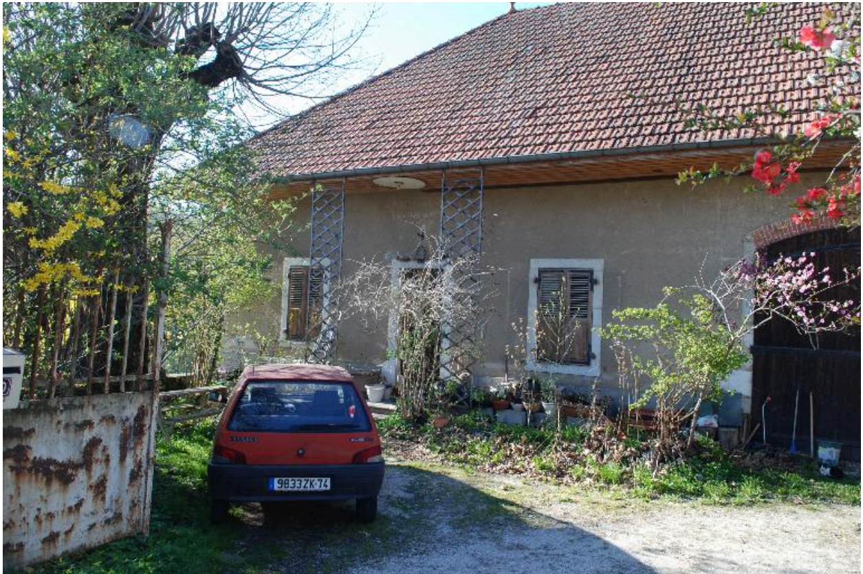
Vue partielle de la partie gauche de la façade principale.
