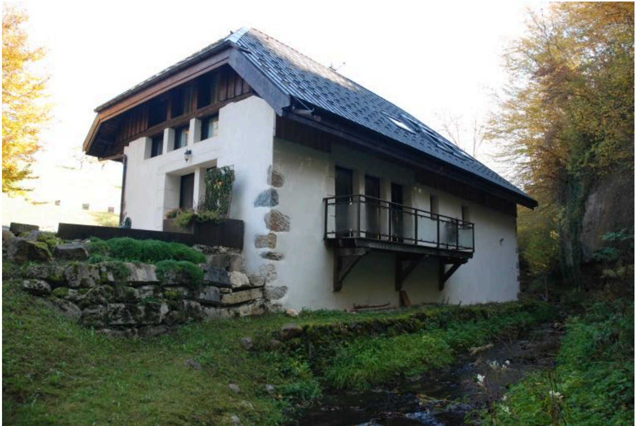
Vue d'ensemble de l'ancien moulin, face arrière sur le ruisseau.
