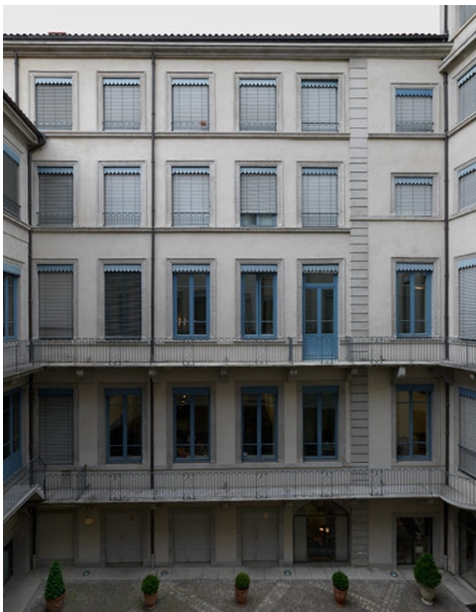
Vue de l'élévation ouest de la cour
