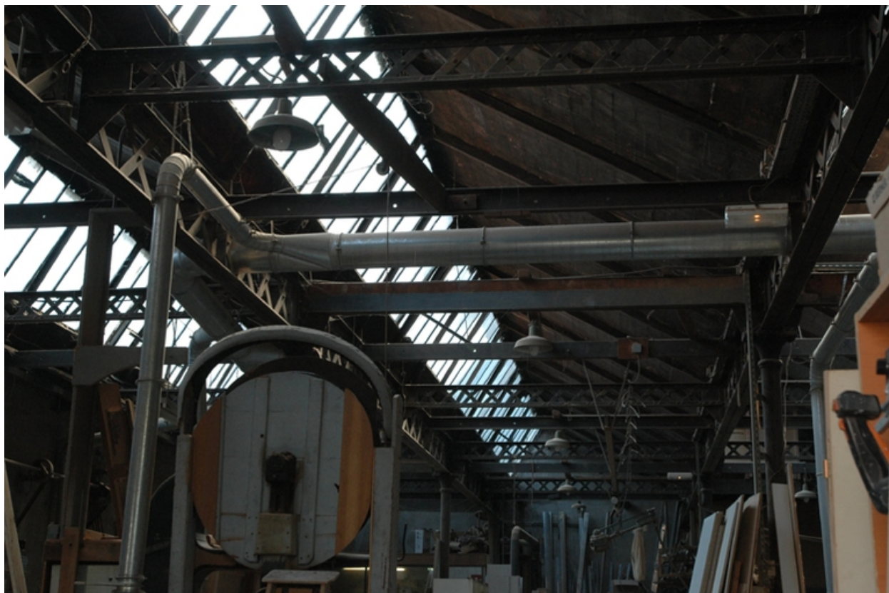
Vue de la charpente métallique
