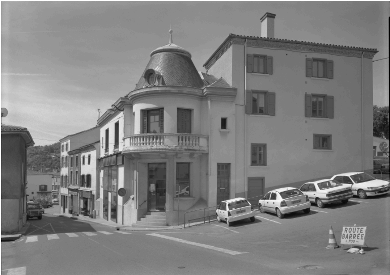
Vue de la rue de Roanne et de la place Rolle, du nord-est.
