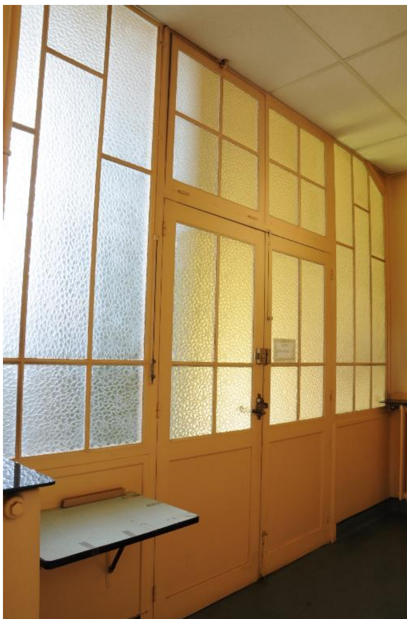
Porte palière, deuxième étage
