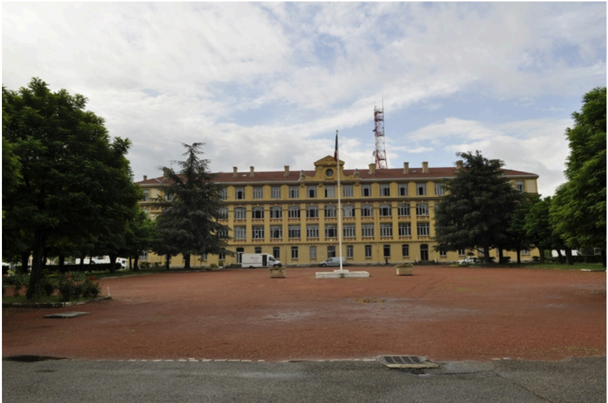
vue du bâtiment de 1916: façade nord.
