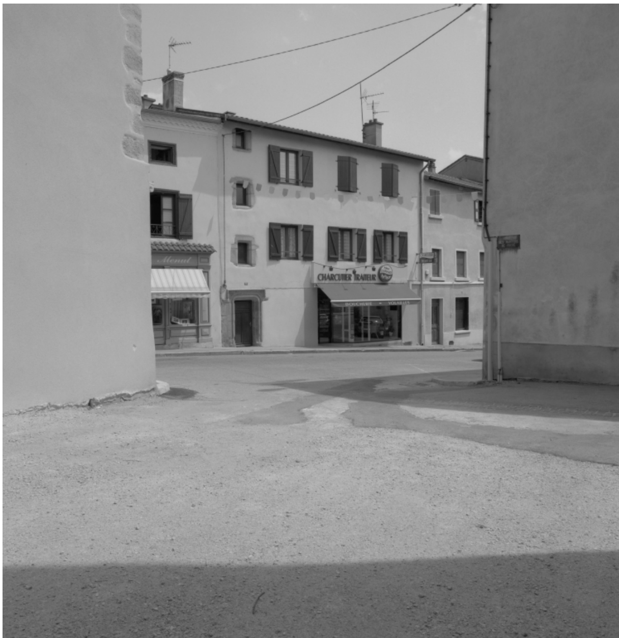
Maison, 11 place de la République. Vue d'ensemble, de l'ouest.
