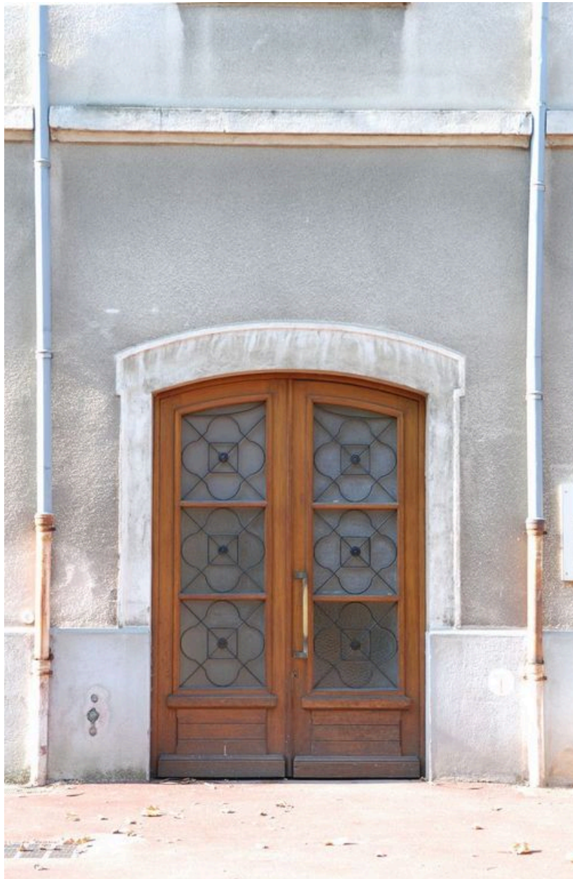
Détail de la façade latérale nord du bâtiment des services généraux : porte en chêne et verre cathédrale
