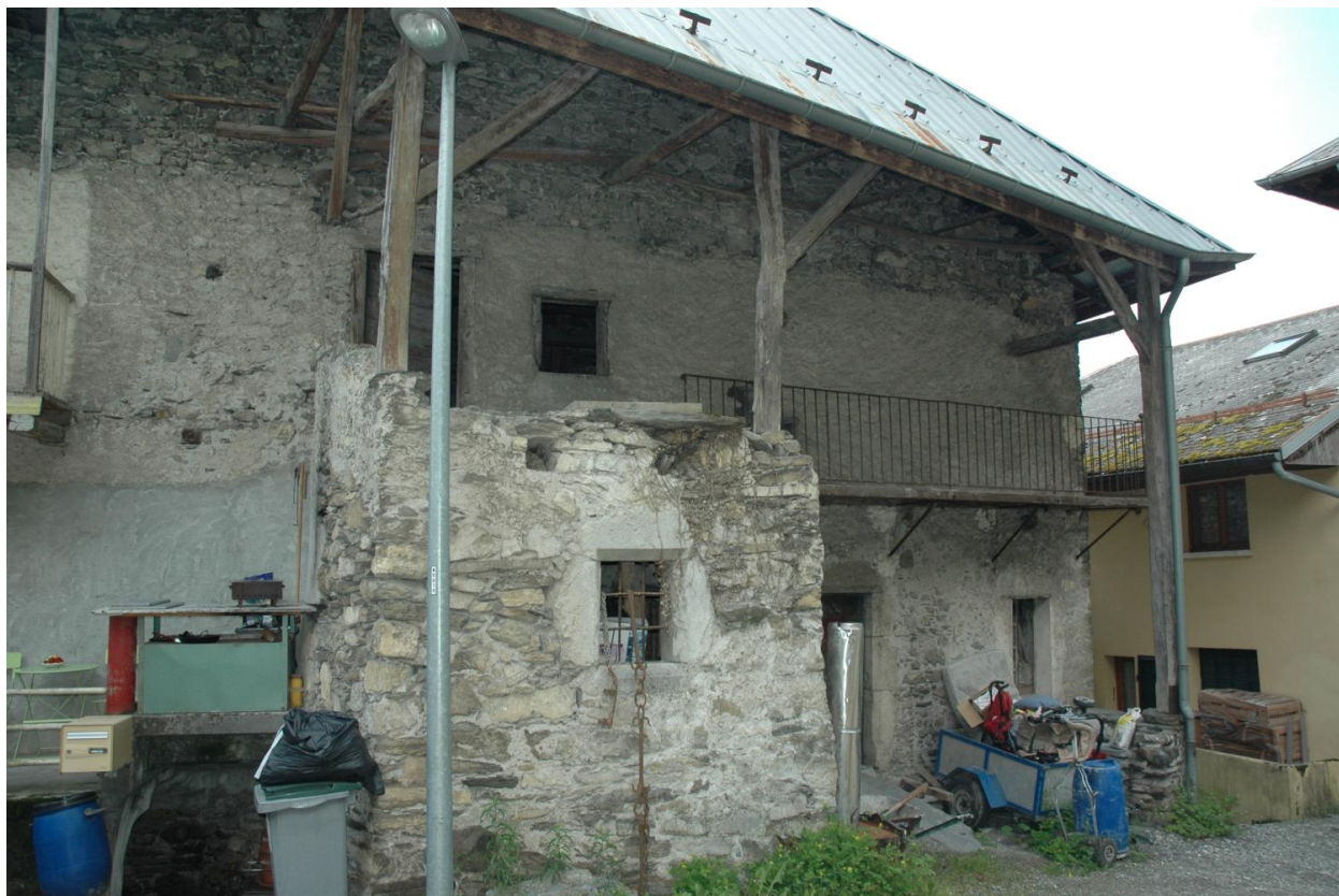
Maison de vigneron mitoyenne (2018 B 425), vue depuis le nord.
