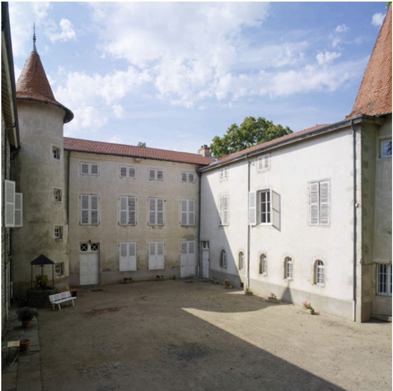
Vue d'ensemble intérieure de la cour, depuis le sud-est.
