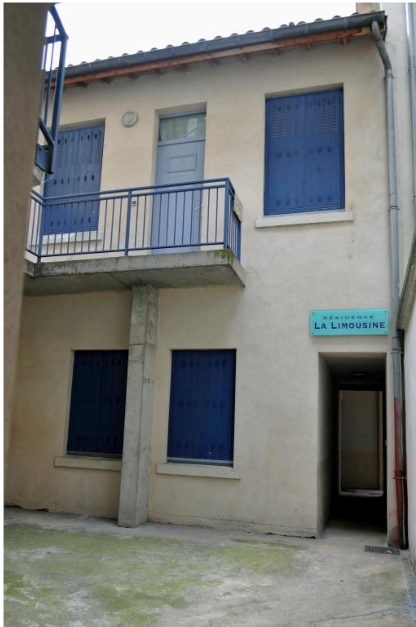
Maison sur cour, avec passage donnant vers la maison en arrière-cour
