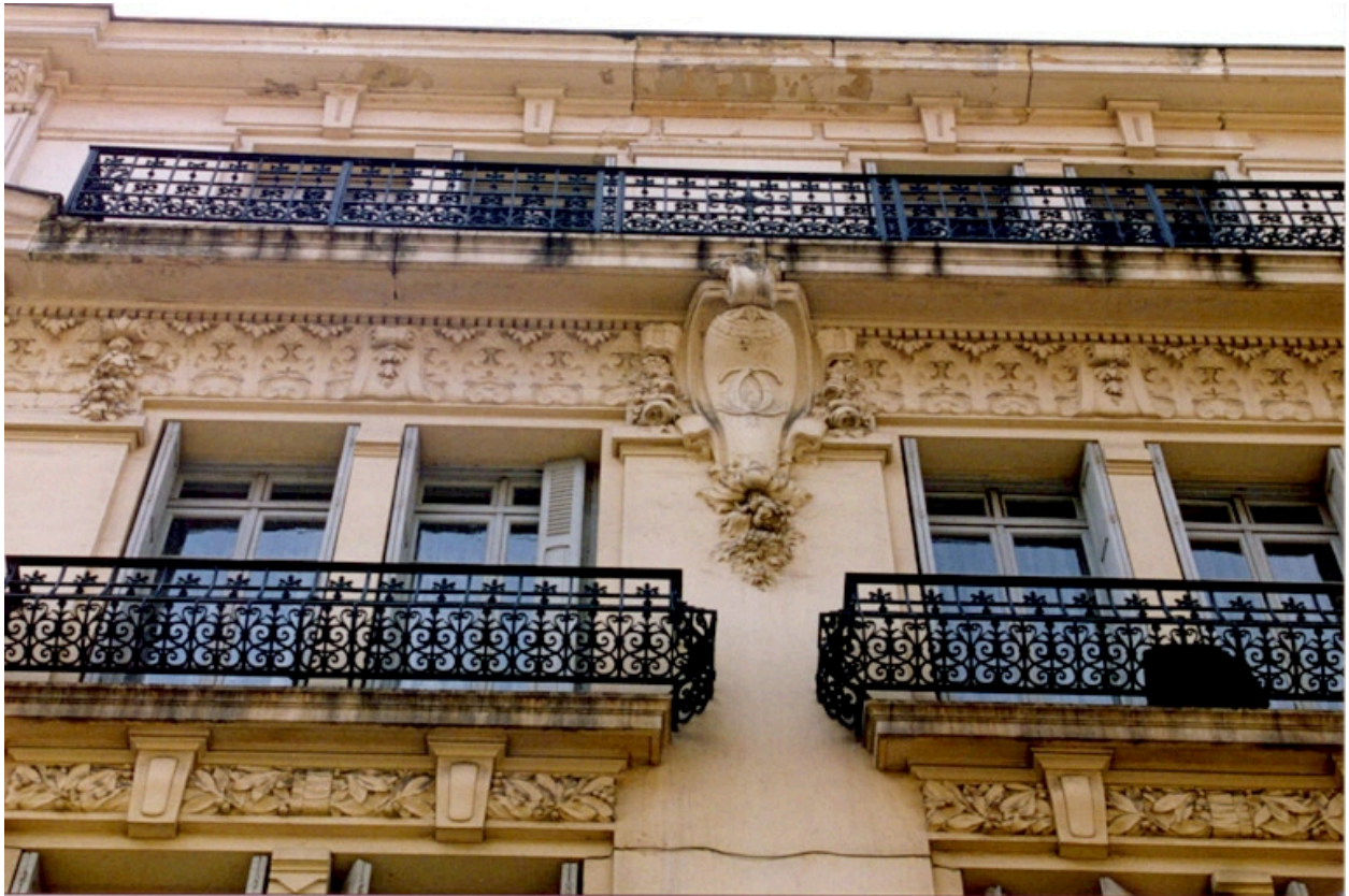
Façade principale. Détail
