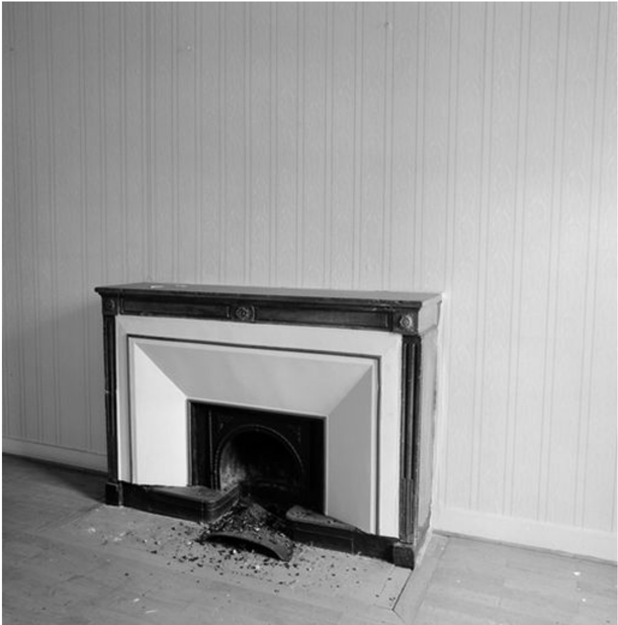
Ancien immeuble, 2e étage, cheminée d'une pièce donnant sur la rue (calcaire à gryphées du Mont d'Or)
