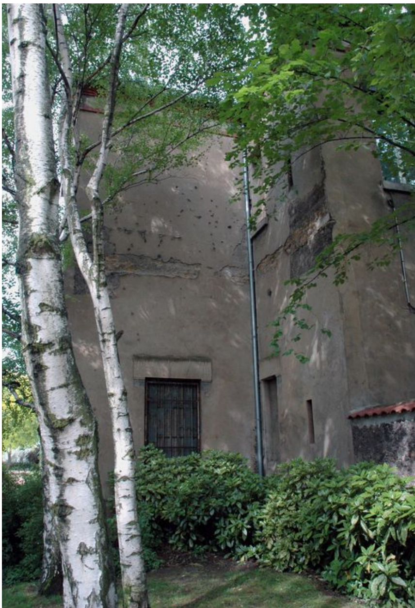
Bâtiment de la galerie, avant-corps est, élévation latérale
