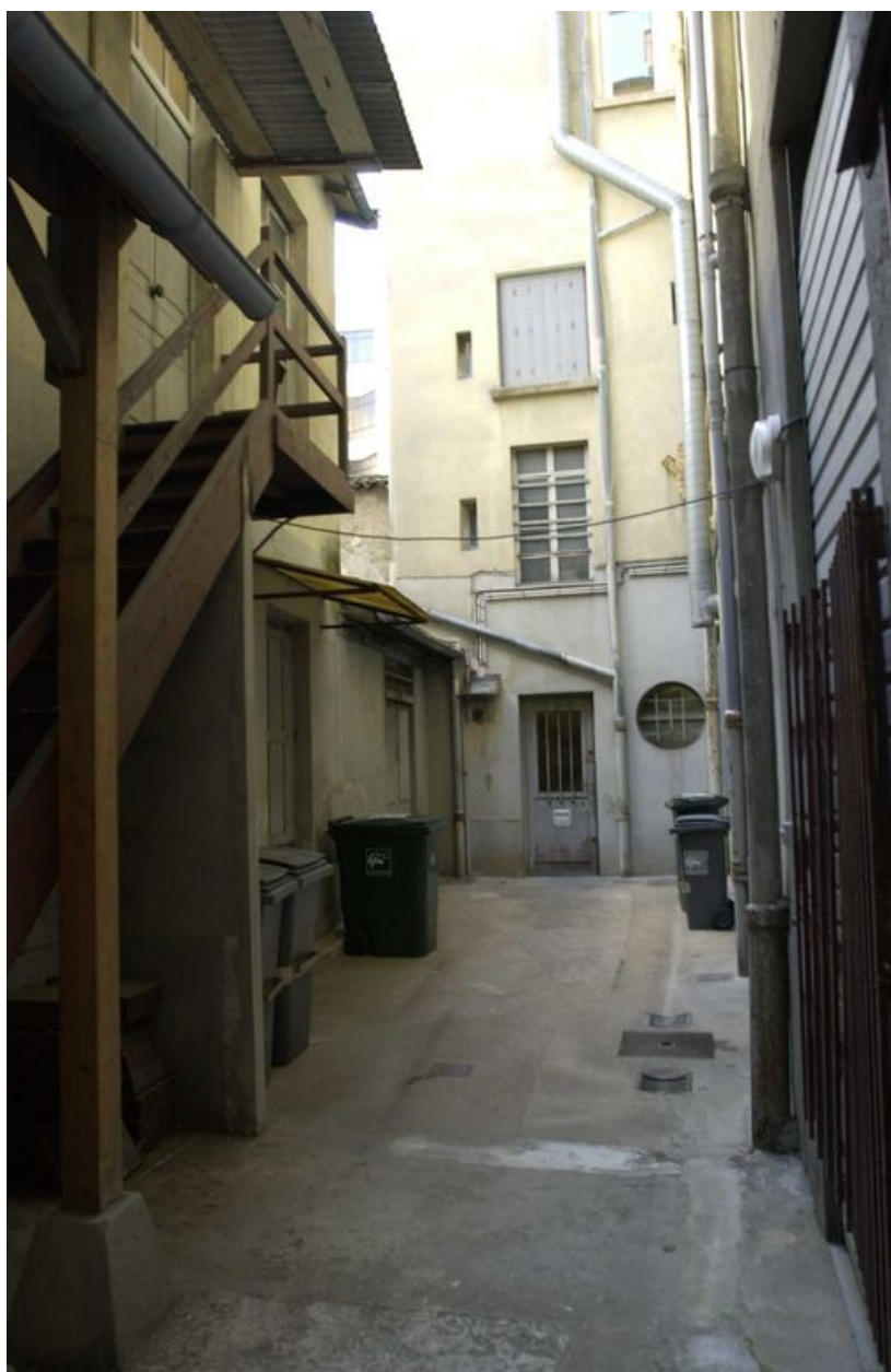
Vue de la cour depuis le sud
