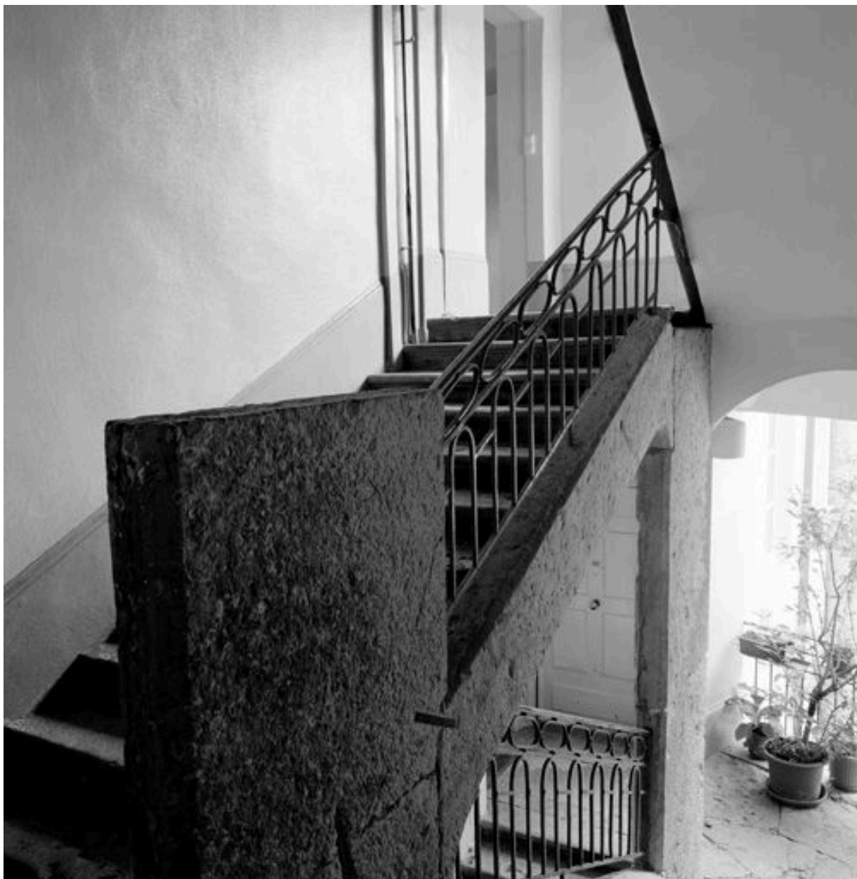
1ère cour, escalier ouest, volées du 4e étage
