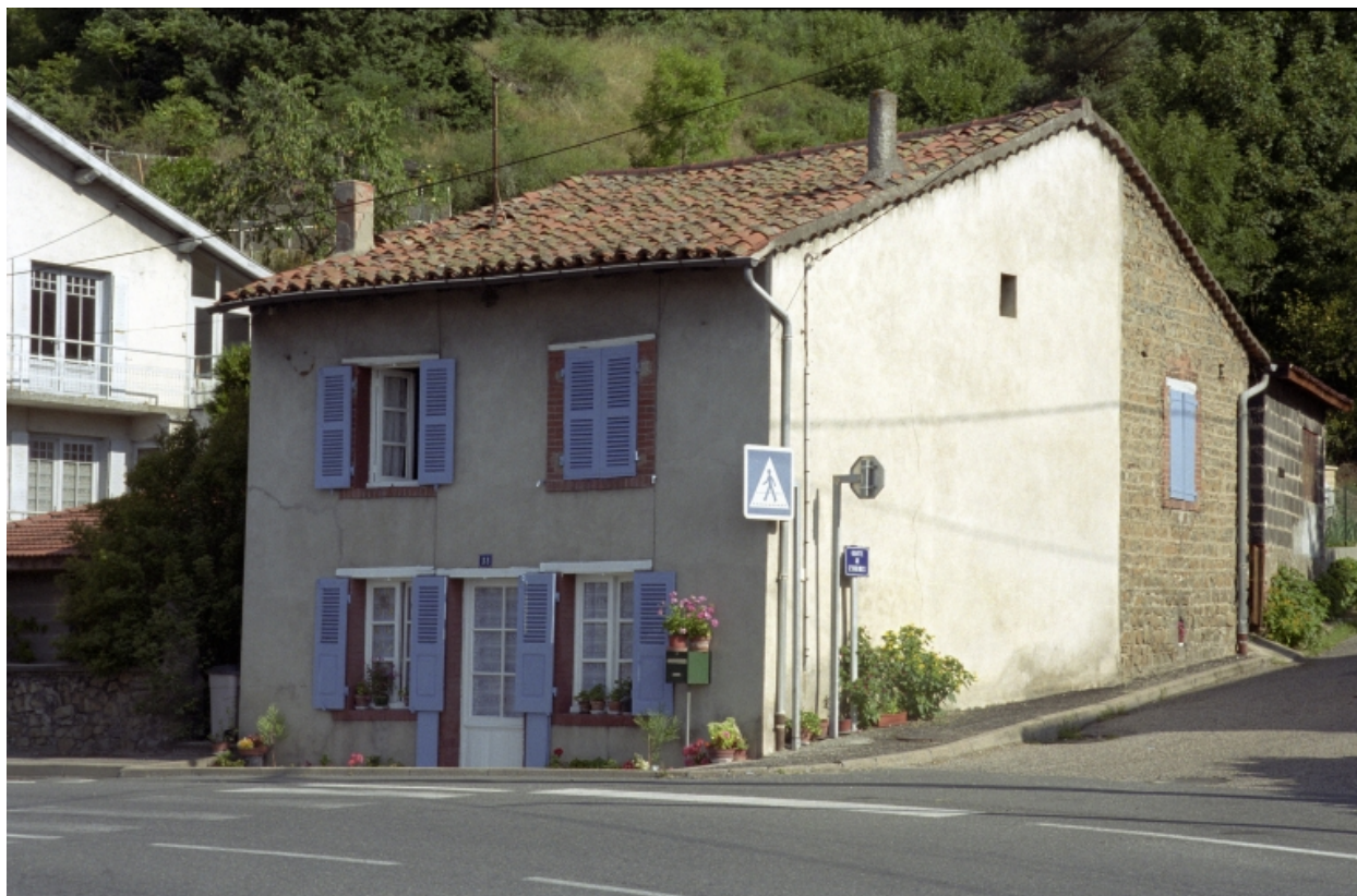
Boën, îlot 19, RN 89, 33. Vue générale de la façade sur rue.
