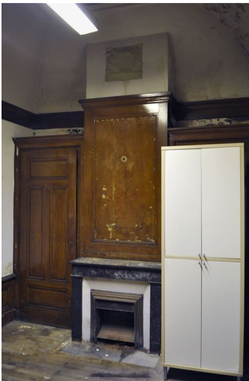
Rez-de-chaussée : ancien bureau du pasteur.
