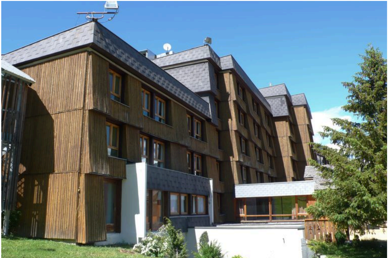
Vue générale depuis le sud
