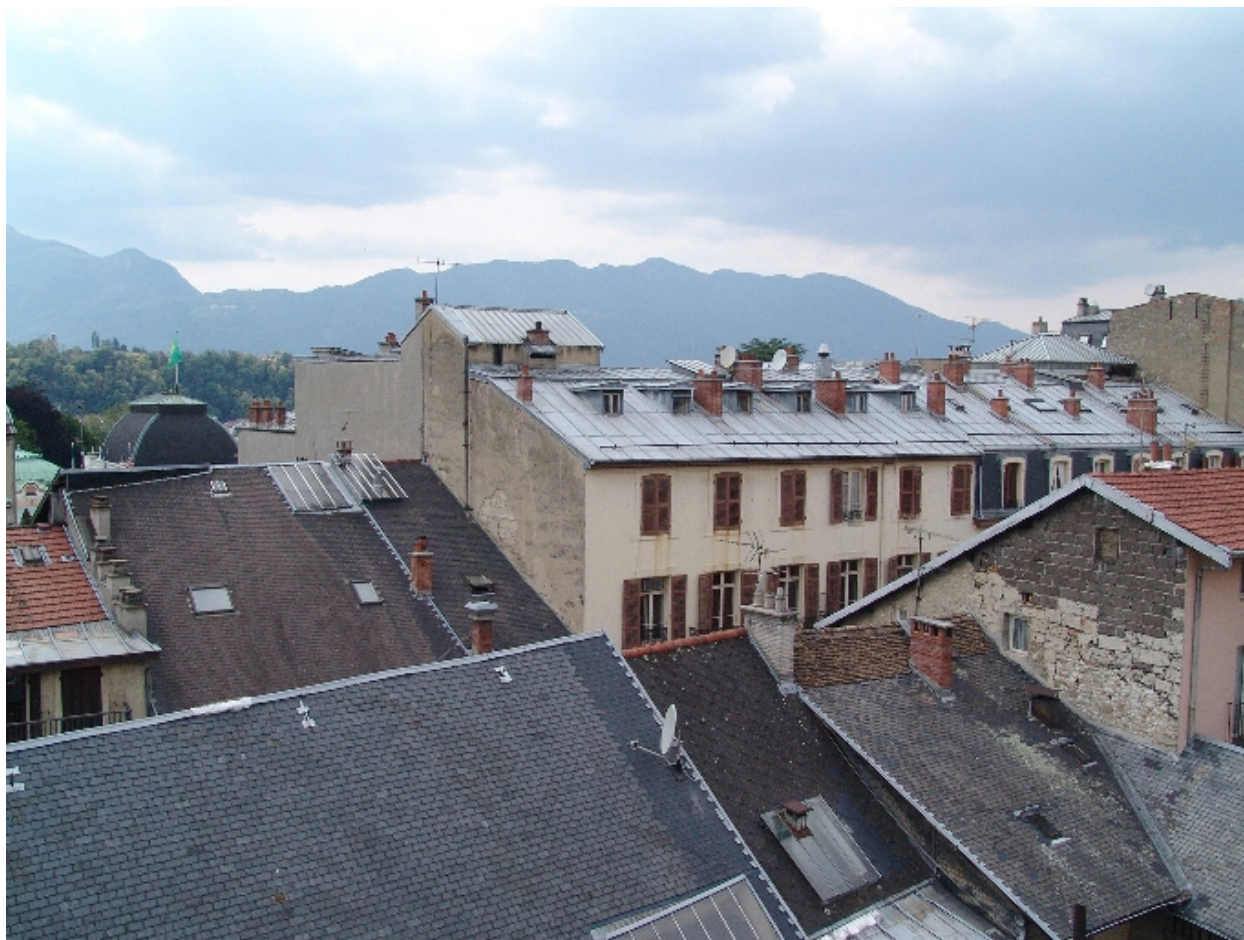
Vue de la partie centrale
