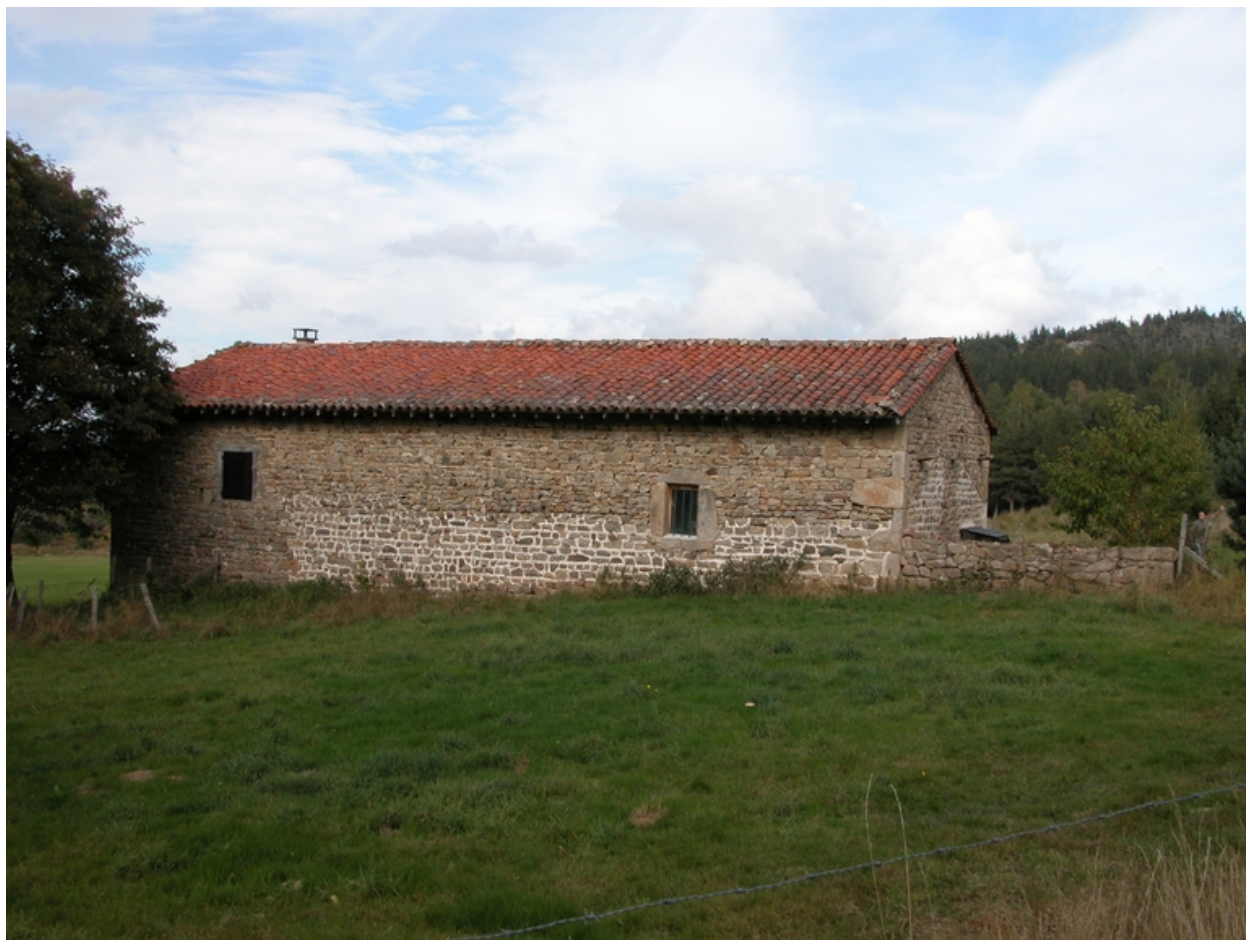
Vue de l'élévation postérieure.
