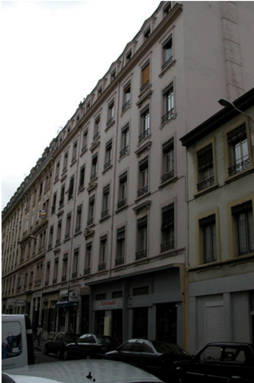
Elévation principale depuis le sud
