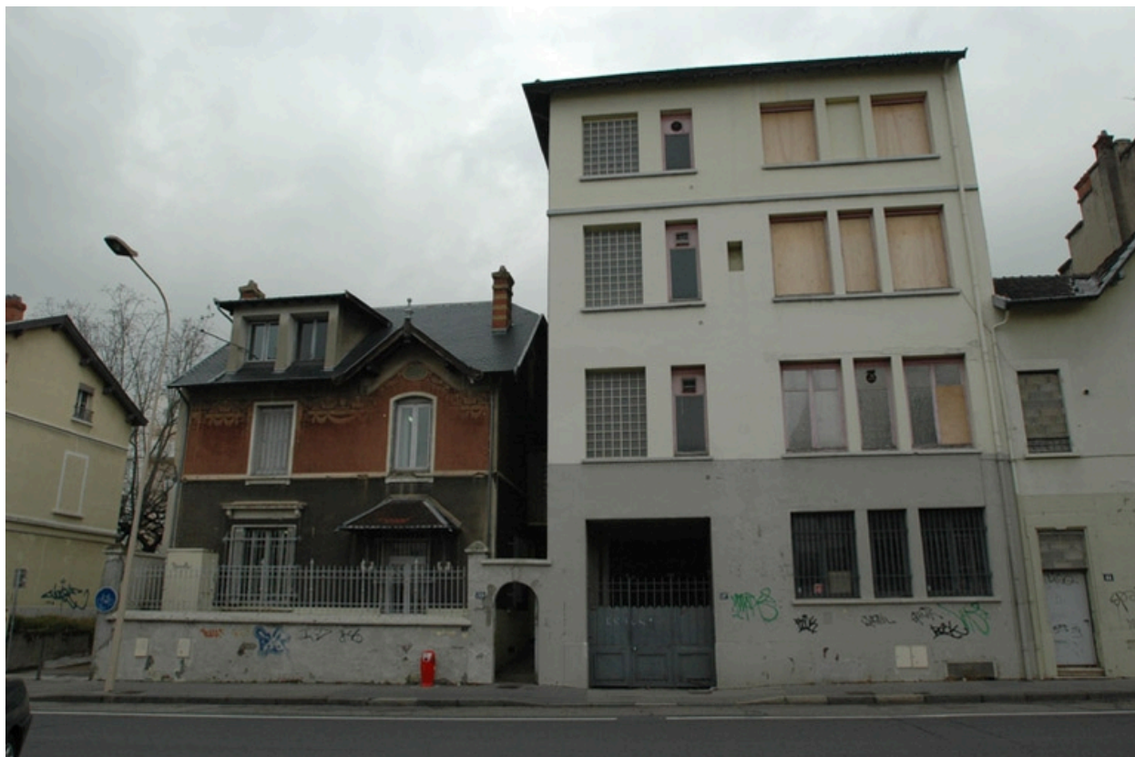
Vue générale, avenue Lacassagne
