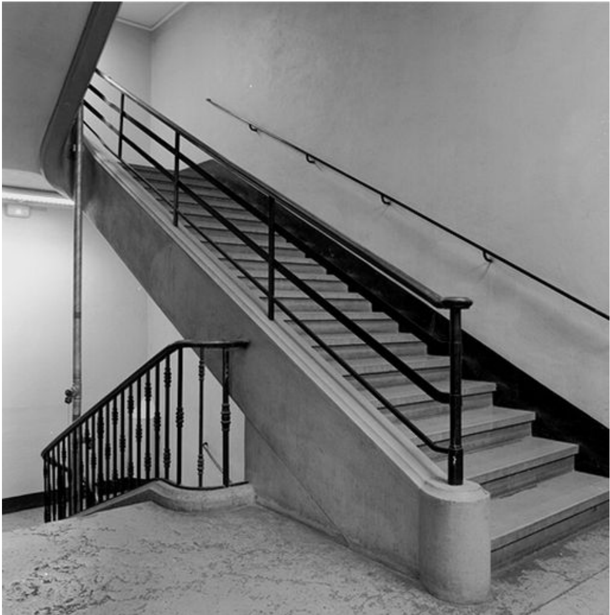
Bâtiment principal, corps central, escalier nord, départ de la surélévation de l'escalier sur le palier du 3e étage
