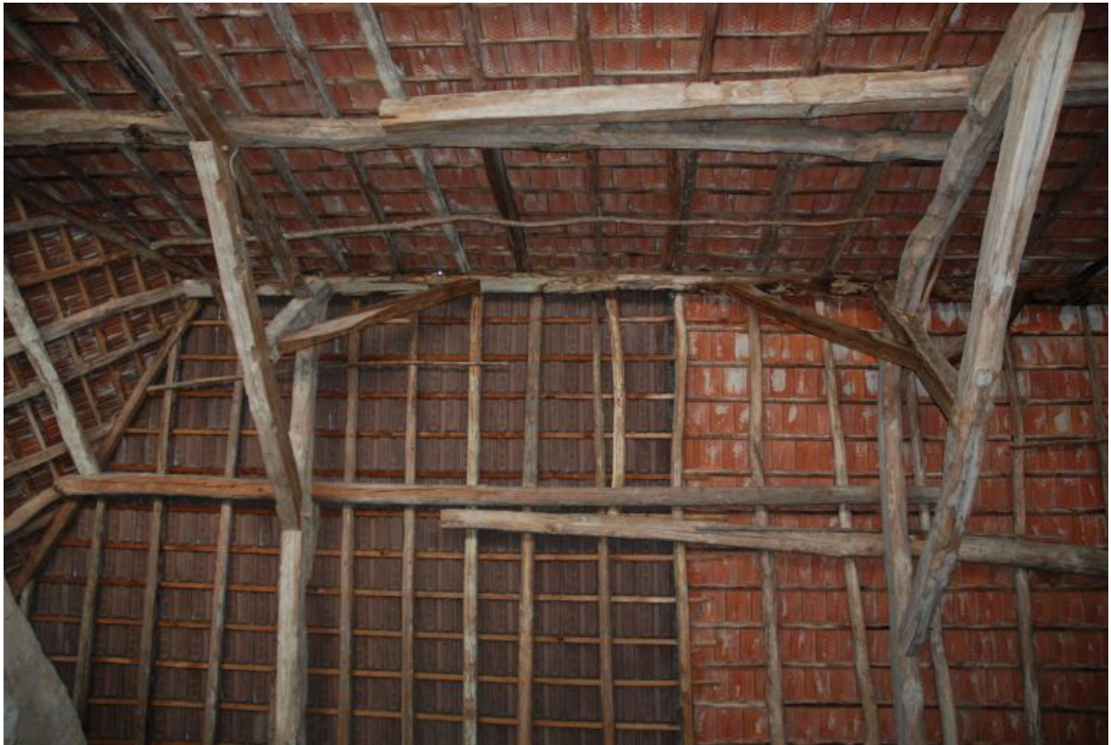
Vue intérieure de la charpente dans la grange.
