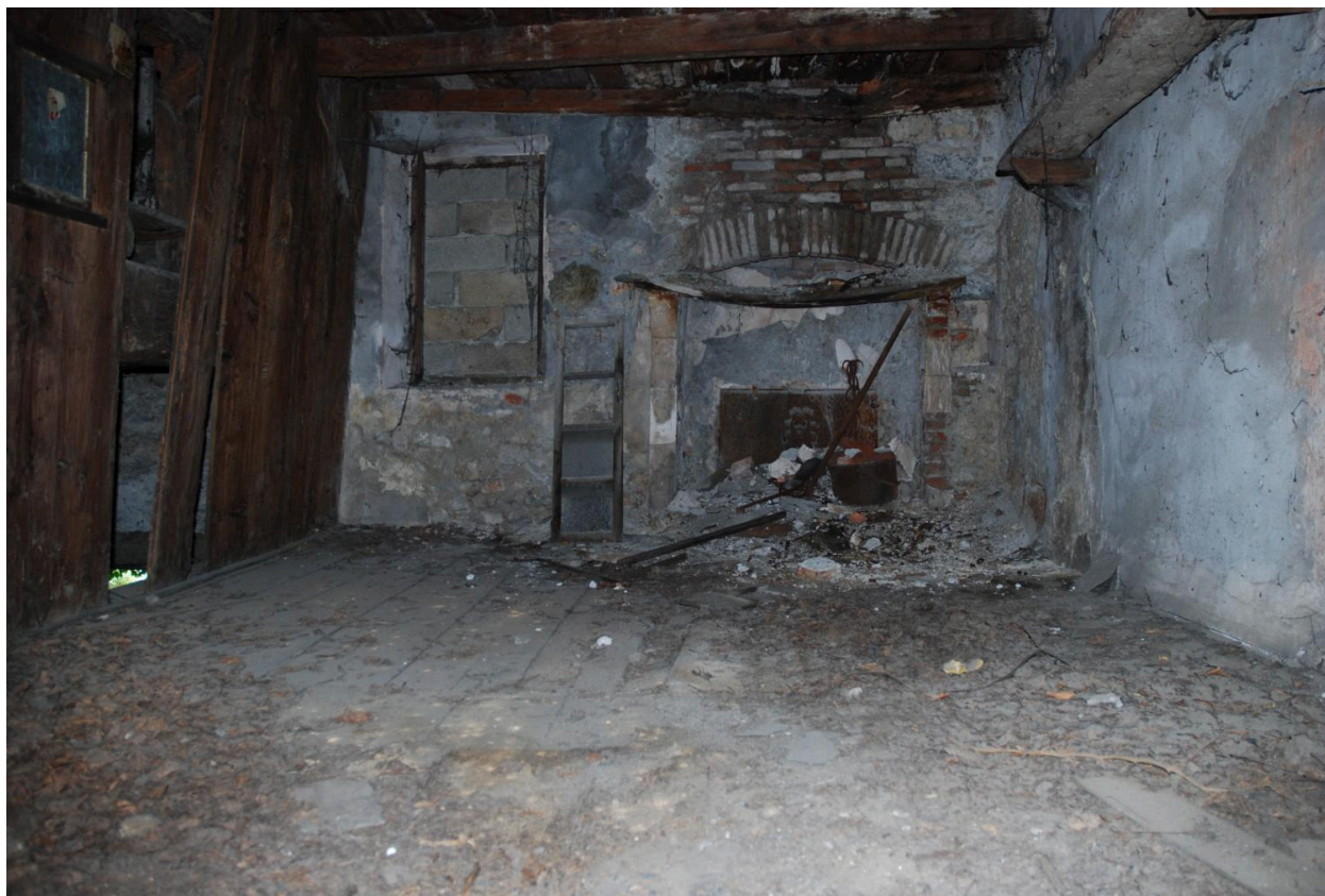
Vue intérieure : mezzanine, cheminée.
