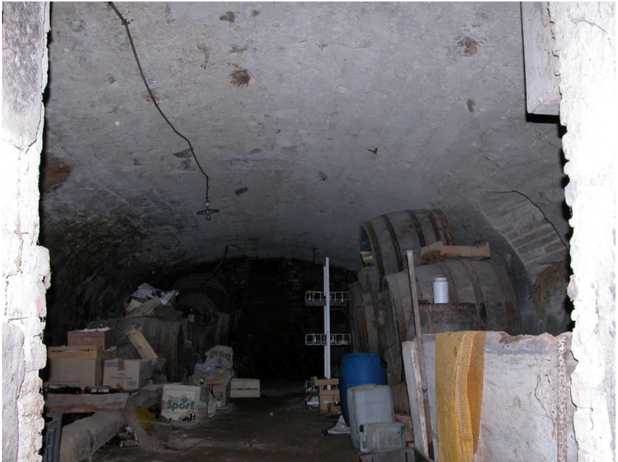
Vue intérieure de la cave.
