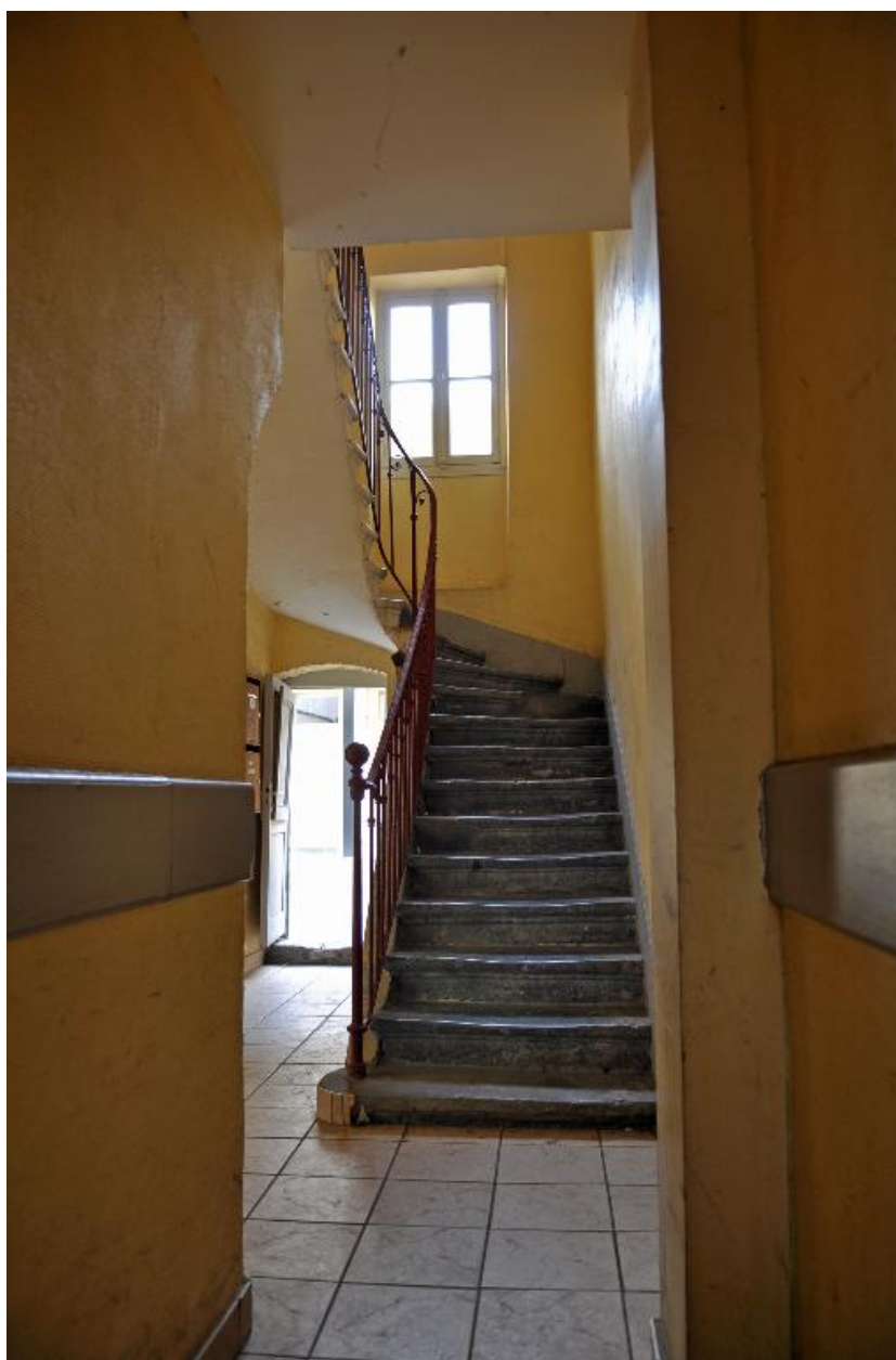
Vue intérieure : le départ de l'escalier
