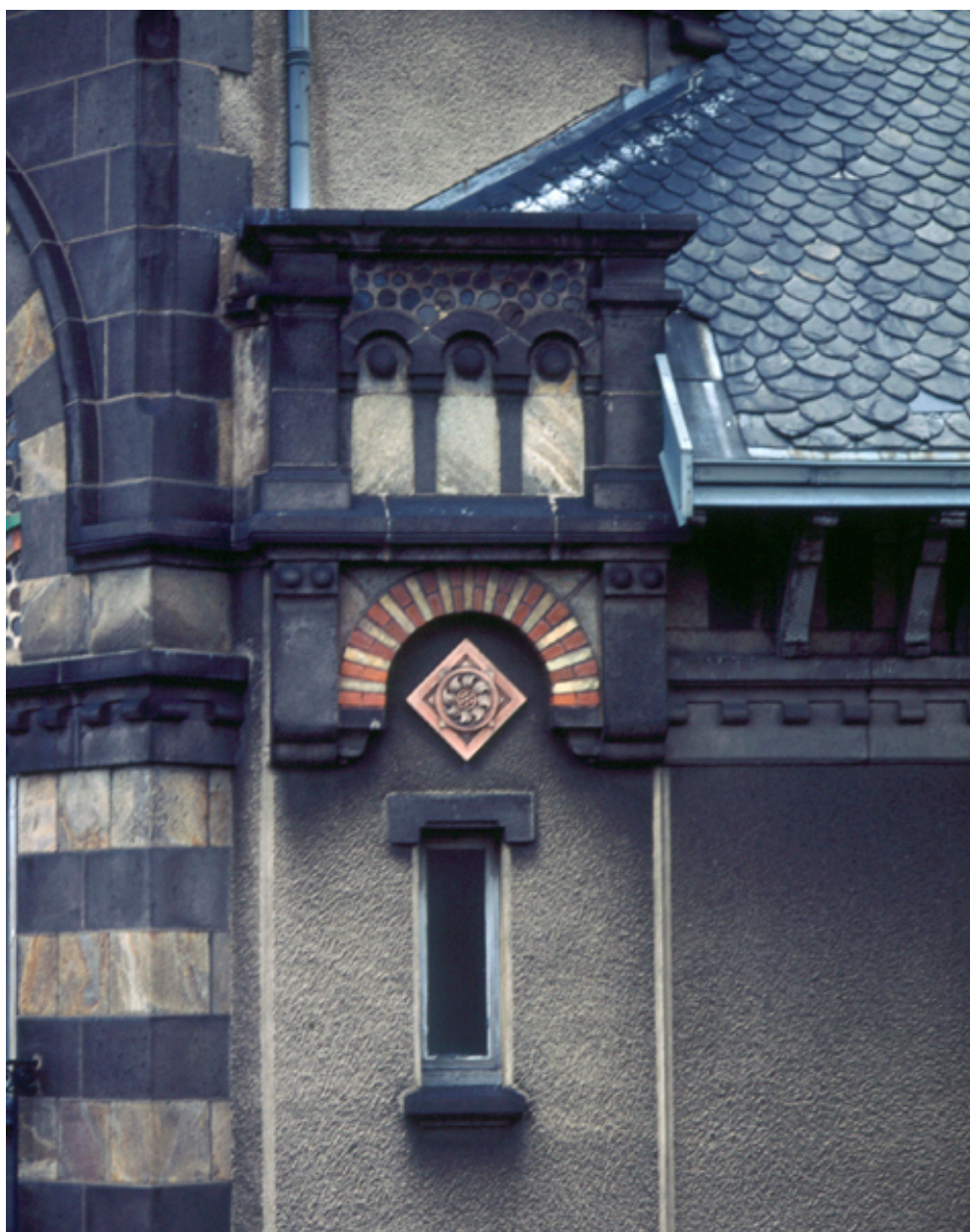
Baie de l'immeuble, dit villa Giraudon, 27 avenue d'Italie
