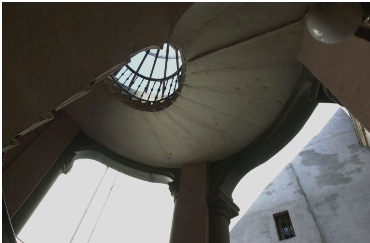
5e étage d'escalier, vue par-dessous
