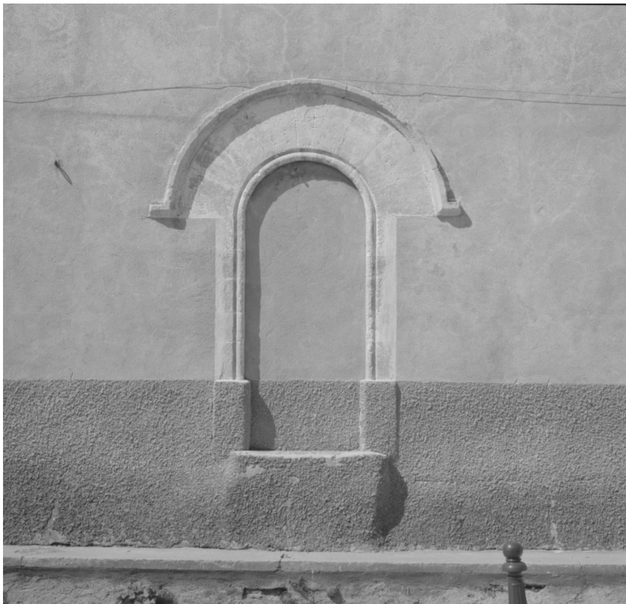
Détail de l'élévation sud : porte latérale murée.
