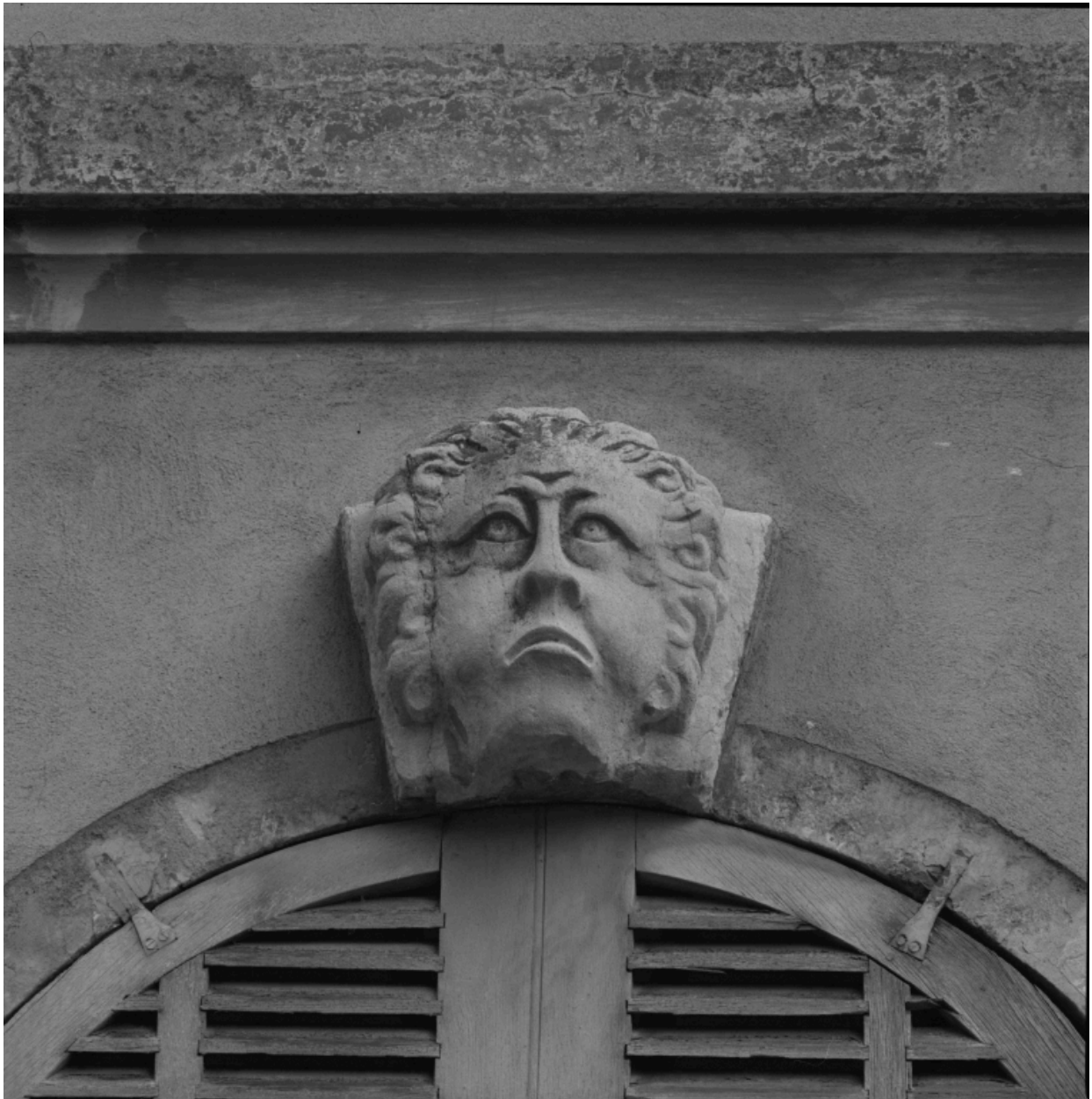
Façade sur jardin, détail : travée axiale, baie latérale gauche, agrafe figurée, vue de face.
