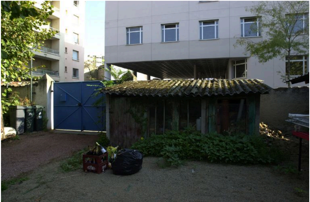
Vue des dépendances accolées au mur de clôture
