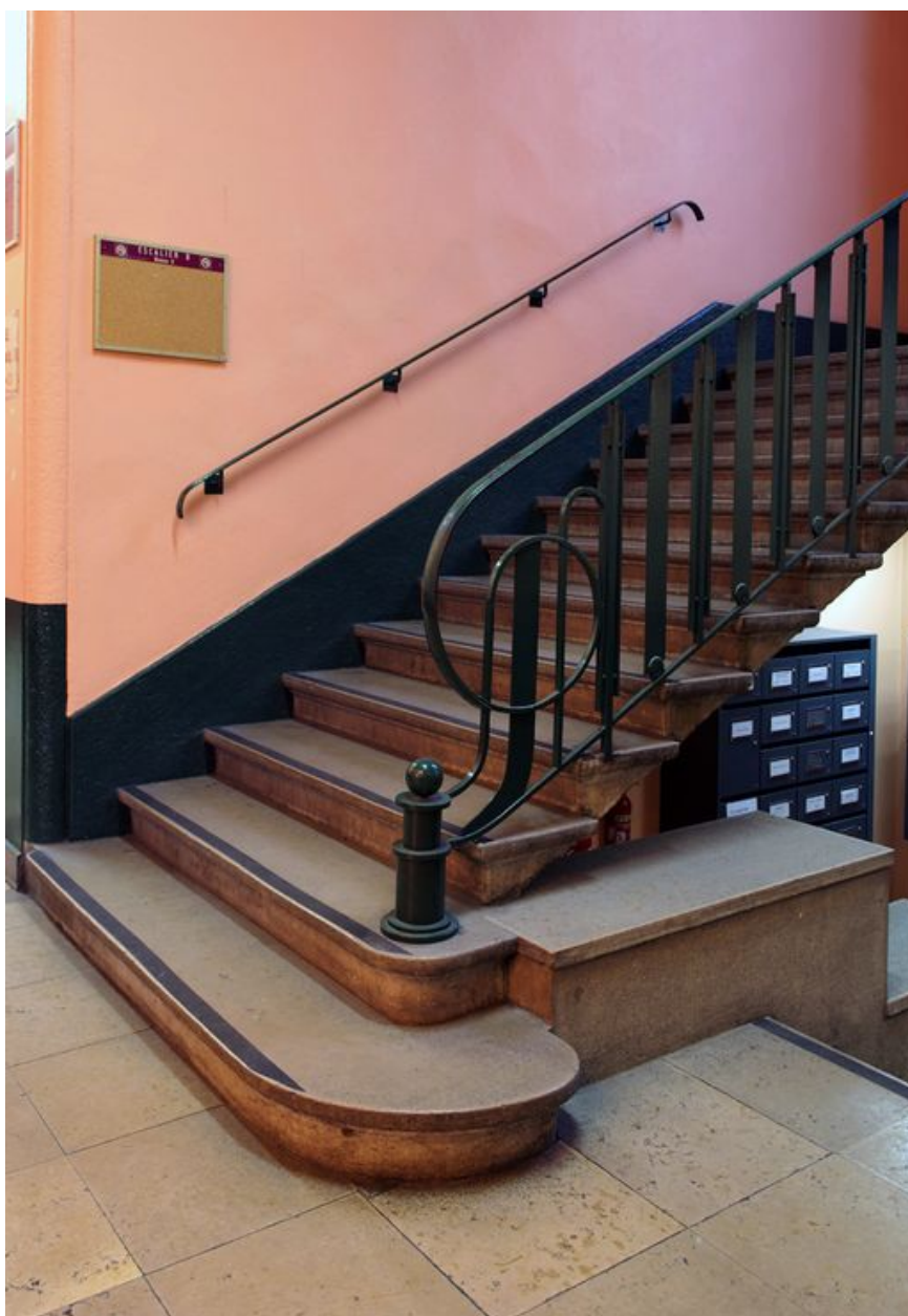
Escalier sud, départ de l'escalier.
