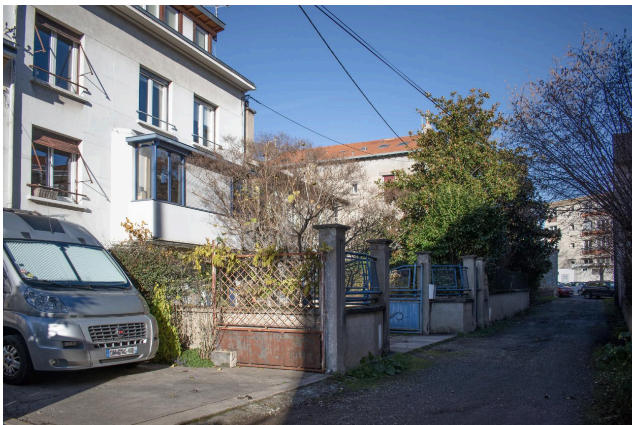
Façade sur la voie de desserte
