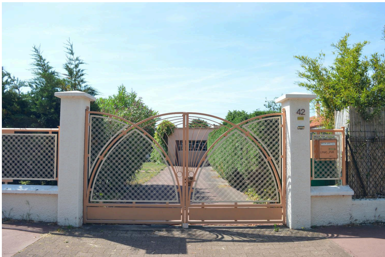
Détail d'un portail et d'un garage du lotissement entre-deux-guerres ?- Avenue du Dr Georges Lévy - mai 2022
