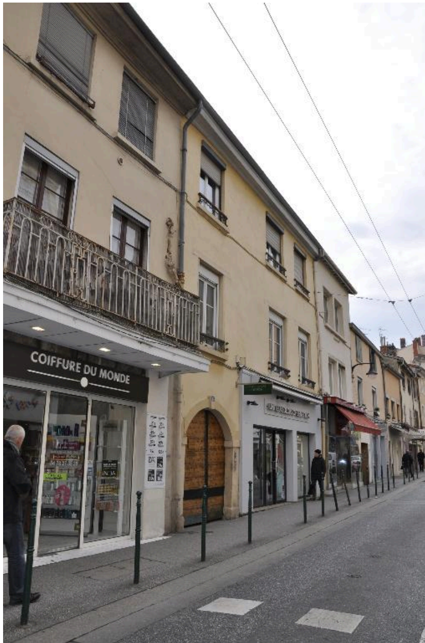
Vue d'ensemble nord ouest
