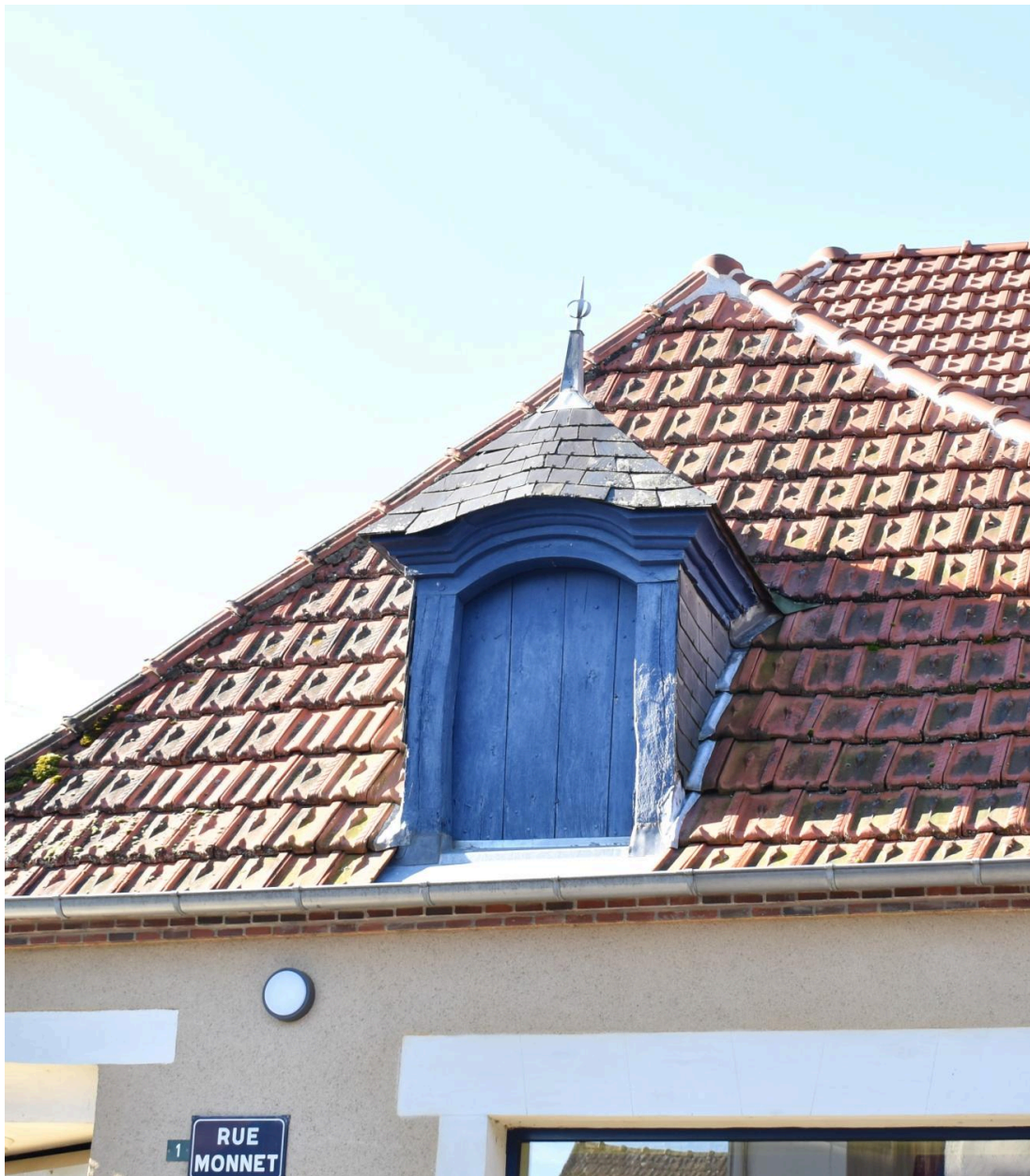
Détail d'une lucarne au linteau cintré du n°1 rue Monnet.
