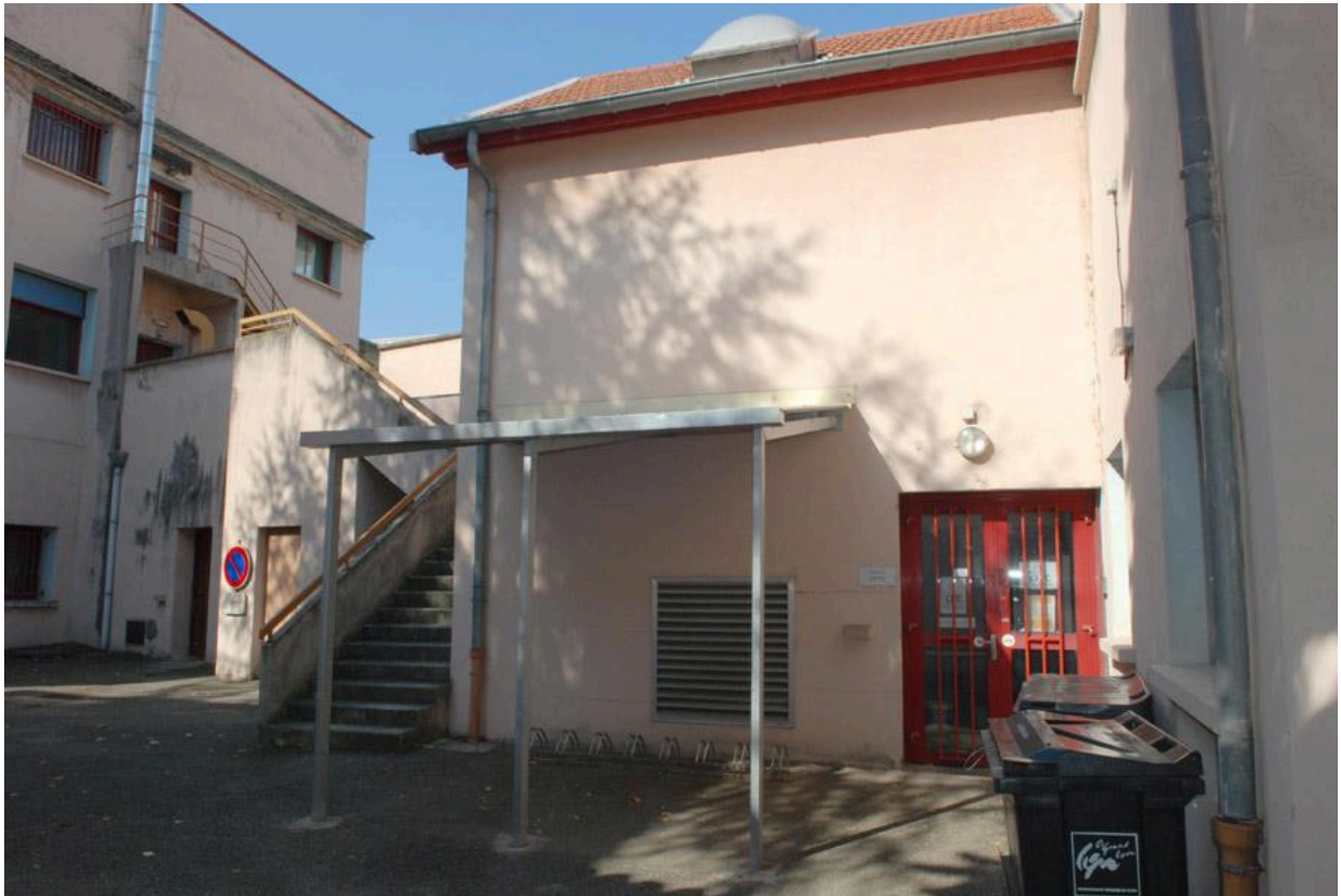
Vue sur cour intérieur
