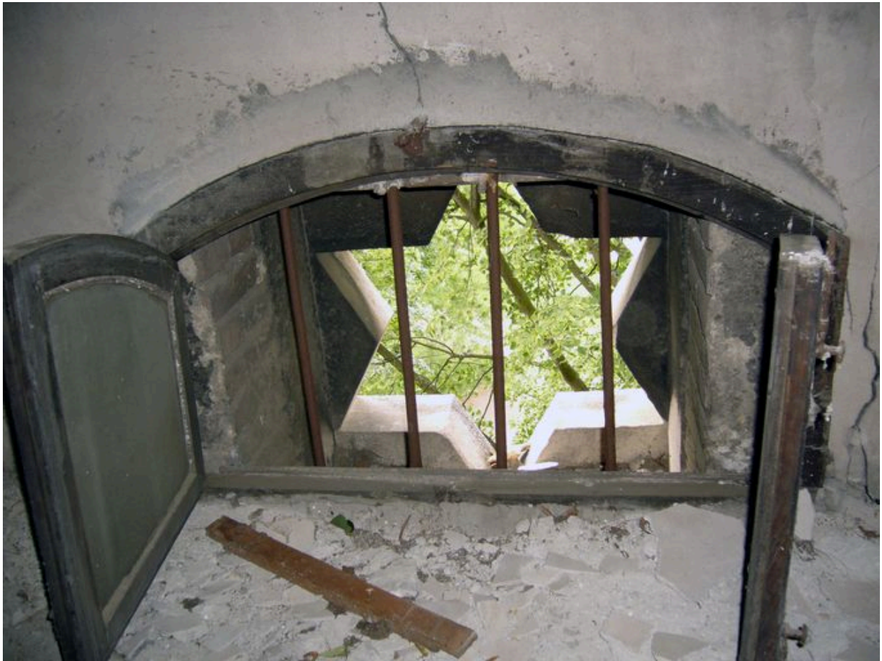
Comble, détail de l'ouverture en forme d'étoile à 6 branches au niveau du tympan
