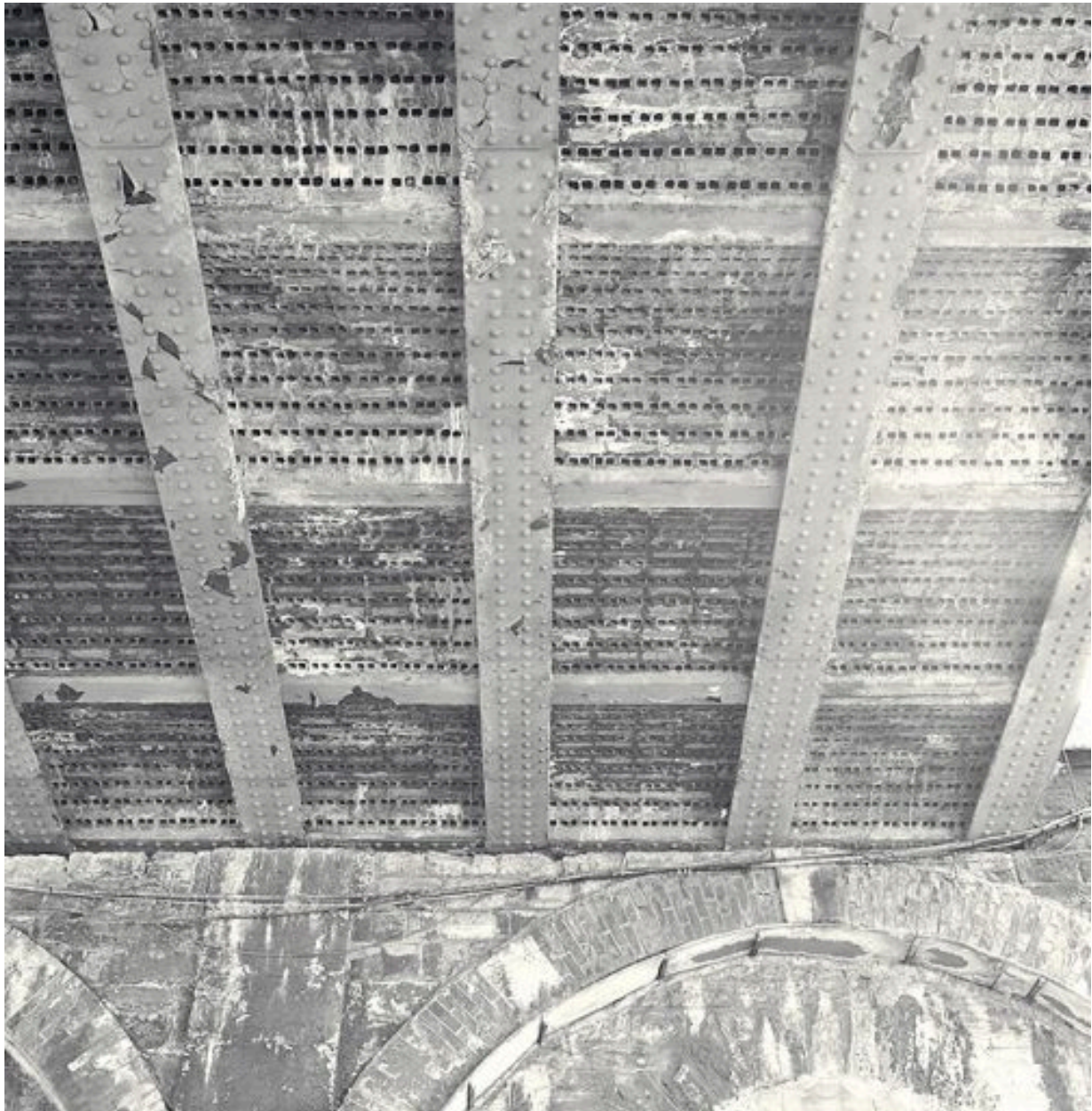
Détail des voûtains des passerelles enjambant la rue du Bélier
