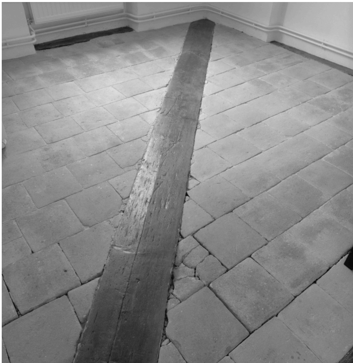
Etage de comble : détail du plancher de la pièce sud-ouest.
