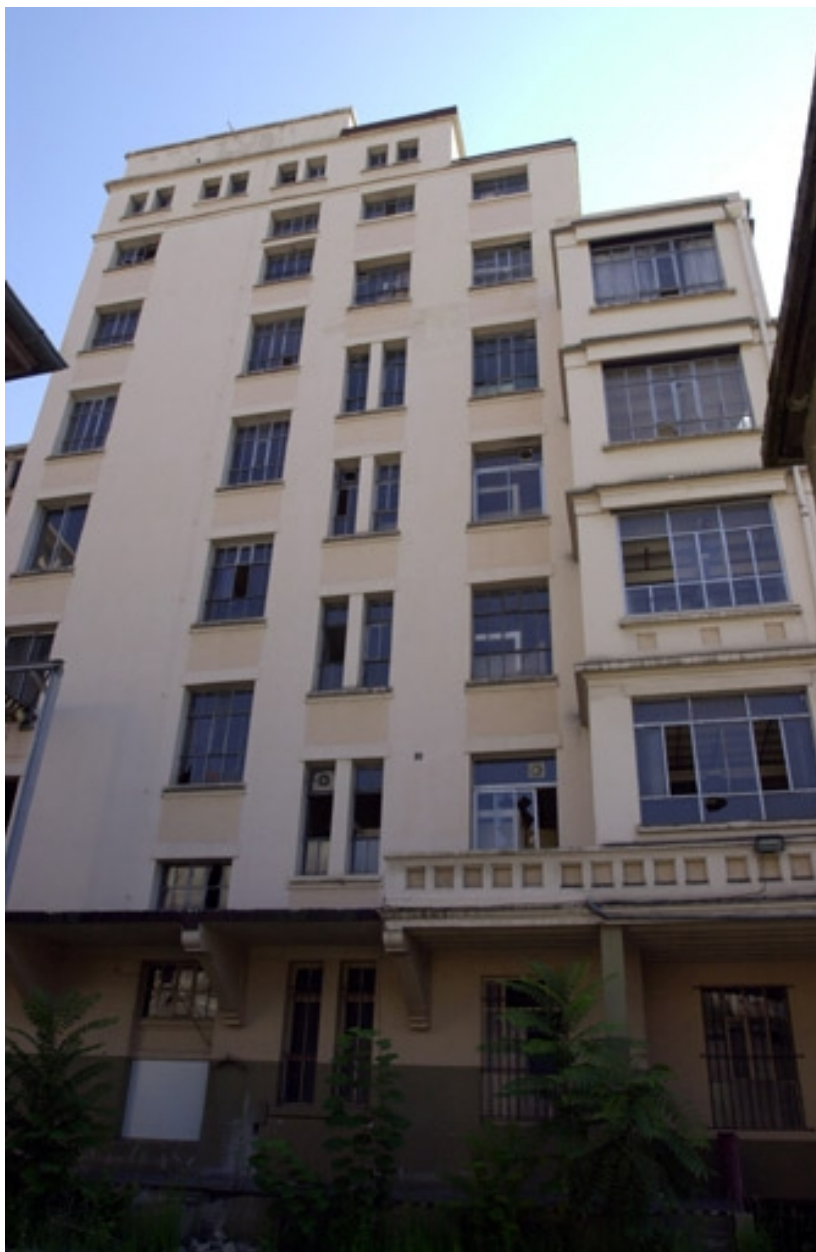
Façade latérale, vue ouest
